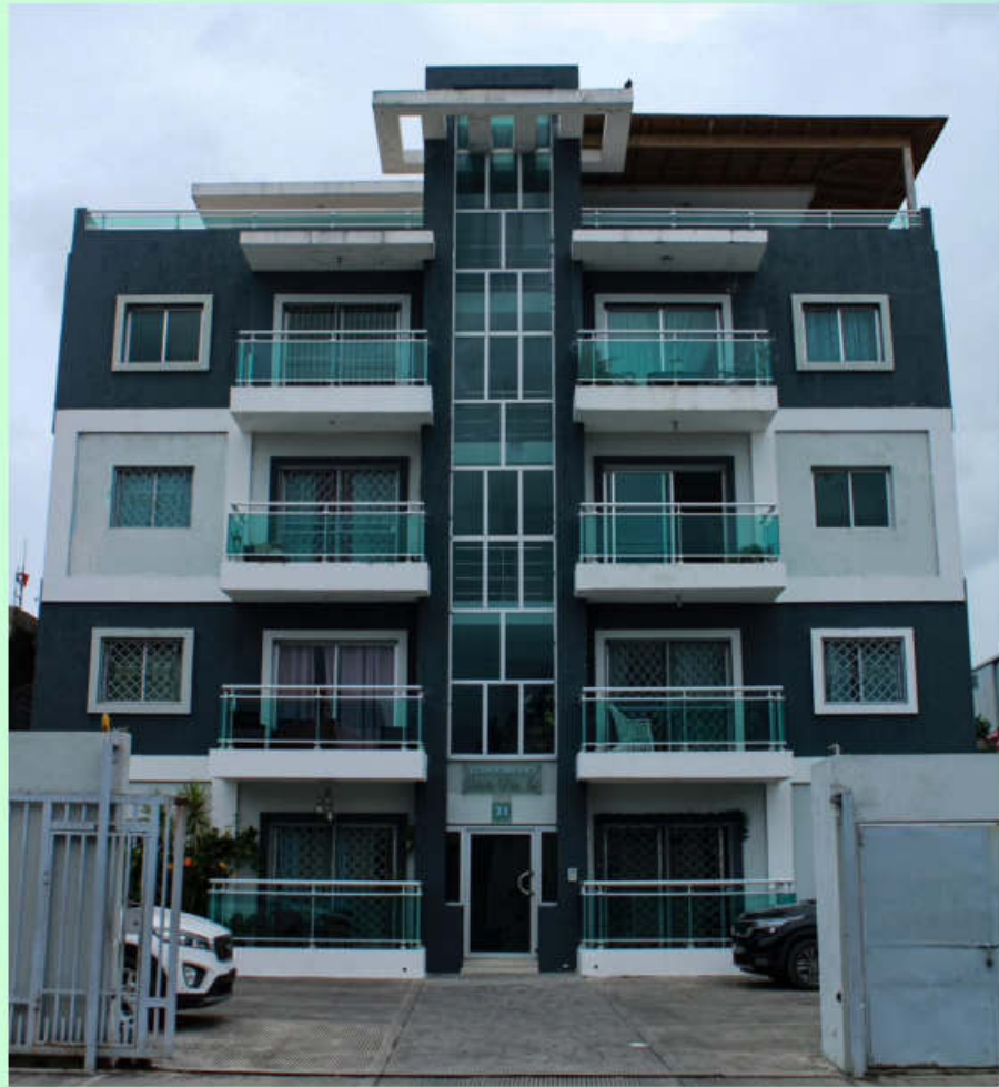
Edificio Don Freddy Año 2015 8 Apartamentos
